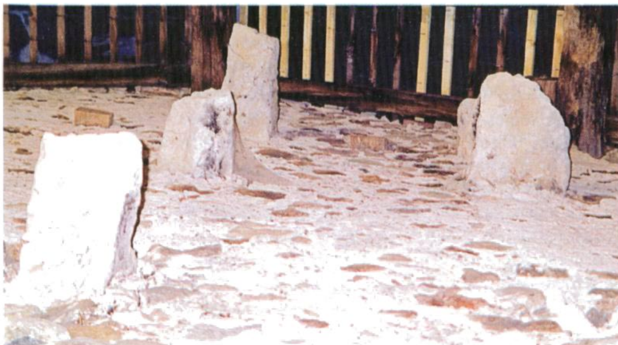
CHEMINÉE DE LA MAISON COMMUNE. Les pierres saillantes guidaient le conduit le long du mur de refend. Le départ de la cheminée conserve encore deux niches
